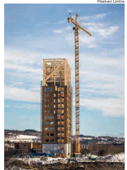
KORKEIN. Oslon pohjoispuolelle nousee 81 metrinen puutalo. Kuva maaliskuulta.
